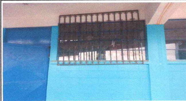
Foto 1: Sustrucción de balcón de metal (modulo 4 de aulas), con hierro entorchado, decoraciones con varilla plana y hierro angular como marco, mas aplicación de pintura anti corrosiva a dos manos.
