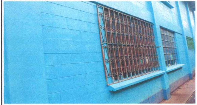
Foto 2: Sustrucción de balcón de metal (modulo 4 de aulas), con hierro entorchado, decoraciones con varilla plana y hierro angular como marco, mas aplicación de pintura anti corrosiva a dos manos.
