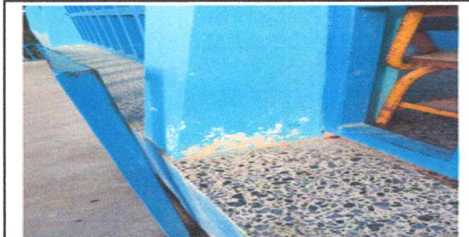
Foto 6: Mantenimiento a barandas de metal (modulo 4), lijado, pulido, cambio de tubos, y aplicación de pintura anti corrosiva
