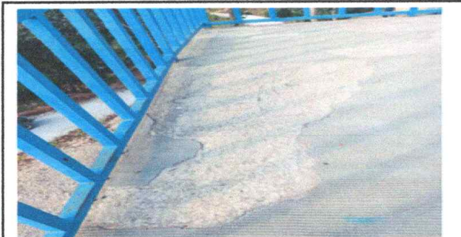
Foto 5: Mantenimiento a barandas de metal (modulo 4), lijado, pulido, cambio de tubos, y aplicación de pintura anti corrosiva
