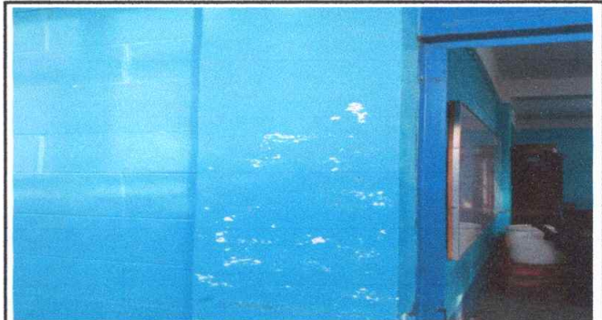
Foto 4: Pintura en muros interiores y exteriores (modulo 4 de aulas), con pintura de latex Excellto de Sherwin Williams
